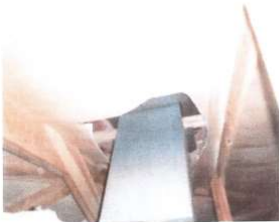
11-12. Aluskate osin läpivientijuurissa tiivistämättä ja viemärin tuuletusputki eristämättä
