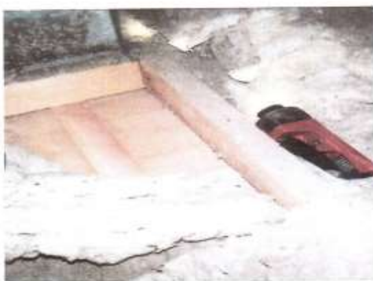
Ullakolla läpivientijuuren alla villoja (roskia ulkoa päällä) avattiin, villat kuivat muovipinnassa ei kosteusjälkiä
