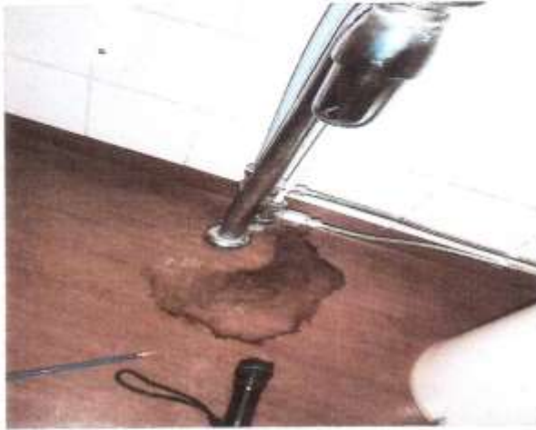
19-20. Liiketila 1:n wc:ssä putkiliitin ja hajulukko tihkuu sekä kokoustilan iv-venttiilit puuttuu (kytkinmuutos kesken)
