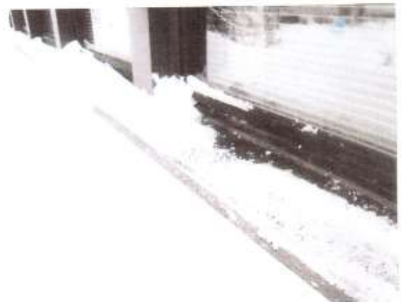
5-6. Tiilimuurin tuuletus alaosasta porareian kautta?. Ikkunoiden vesipellin kallistus paikoin puuttuu
