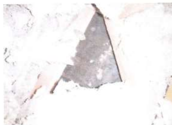
Ullakolla läpivientijuuren alla villoja (roskia ulkoa päällä) avattiin, villat kuivat muovipinnassa ei kosteusjälkiä
