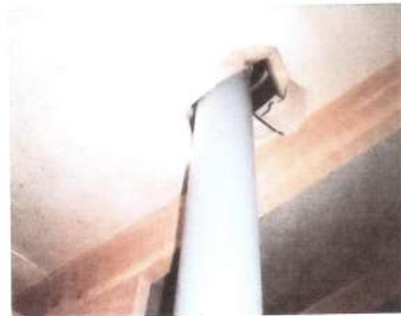
11-12. Aluskate osin läpivientijuurissa tiivistämättä ja viemärin tuuletusputki eristämättä
