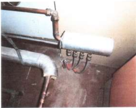
21-22. Teknisessä tilassa mattosaumaa "auki" ja katosta levypala/höyrynsulku puuttuu
