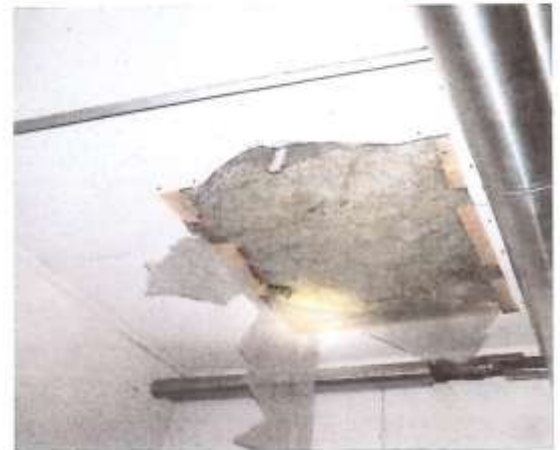
21-22. Teknisessä tilassa mattosaumaa "auki" ja katosta levypala/höyrynsulku puuttuu
