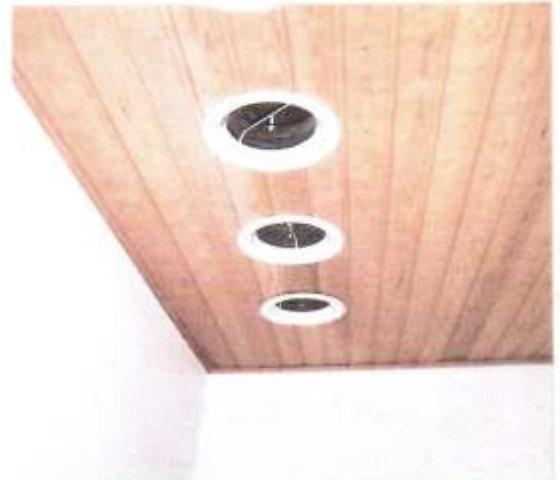
19-20. Liiketila 1:n wc:ssä putkiliitin ja hajulukko tihkuu sekä kokoustilan iv-venttiilit puuttuu (kytkinmuutos kesken)
