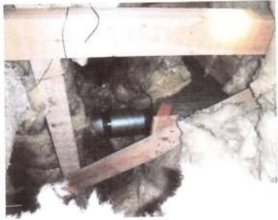
9-10. Ullakolla paikoin ilmanvaihtoputkien eristevilla irronnut, kiinnitys rautalangalla ei pelkällä teipillä
