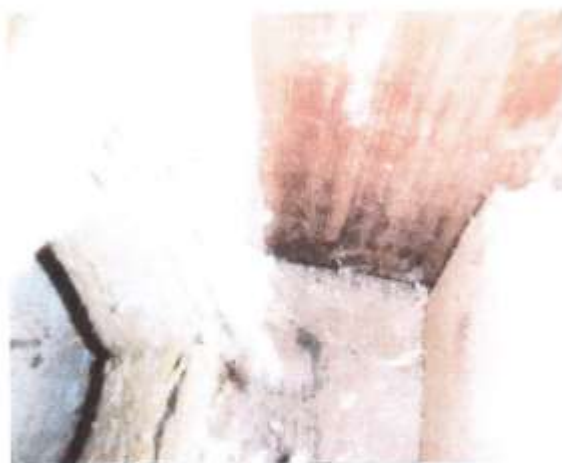
25-26. Ulkoseinää avattiin etusivulla, seinärungossa kosteusarvot ok, samoin, puu- ja villaosat. Vaiesokkelin takana ilmarako
