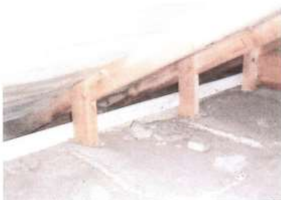
13-14. Ullakolla osin tuuliohjaimia räystäällä ei ole, osin laitettu pihasivulle ja katupäähän 2008 (roskia ulkoa villojen päällä?)
