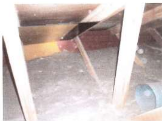
13-14. Ullakolla osin tuuliohjaimia räystäällä ei ole, osin laitettu pihasivulle ja katupäähän 2008 (roskia ulkoa villojen päällä?)
