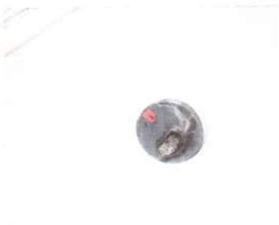
Liiketila 1:n wc:ssä lattiakaivon hajulukko kuiva, viemärin hajua! ja tiloissa pari peitelevyä puuttui
