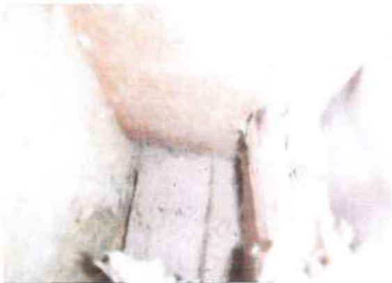
23-24. Ulkoseinää avattiin takasivulla, seinärungossa kosteusarvot ok samoin puu- ja villaosat. Valesokkelin takana ilmarako
