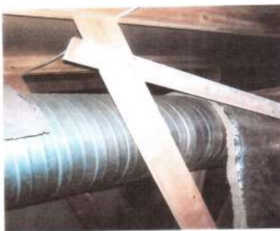
9-10. Ullakolla paikoin ilmanvaihtoputkien eristevilla irronnut, kiinnitys rautalangalla ei pelkällä teipillä
