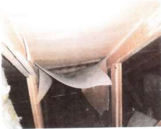
7-8. Tiilikatteen aluskate "auki" parissa kohtaa ullakolia
