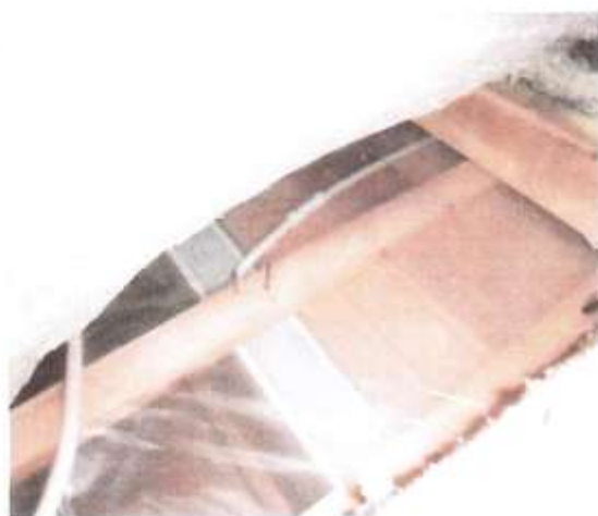
15-16. Räystäällä villa/villa-alus kuivat (kts em tuuliohjaimet). Katolla viemärin tuuletusputki ja iv-pönttö matalat (tuiskulumil)
